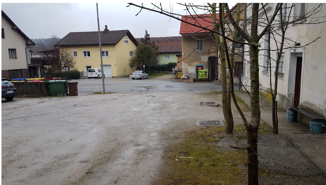
Slika 3 - pogled s parkirišča proti cesti LC 410150
